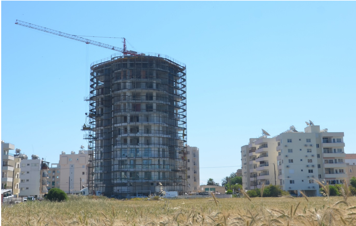
Εικόνα 7.4-3: Υπό κατασκευή πολυώροφο κτίριο, σε απόσταση περίπου 400 μέτρα βορειοδυτικά του Προτεινόμενου Έργου
