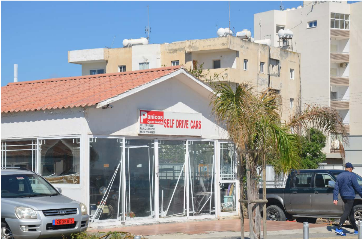
Εικόνα 7.3-2: Κτιριακή εγκατάσταση εντός των τεμαχίων κατασκευής του Προτεινόμενου Έργου
