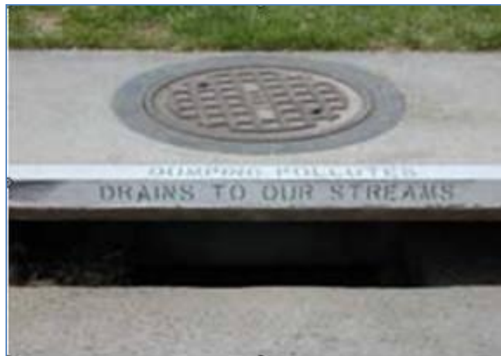
Εικόνα 9-9: Σηματοδότηση συστήματος συλλογής όμβριων υδάτων
