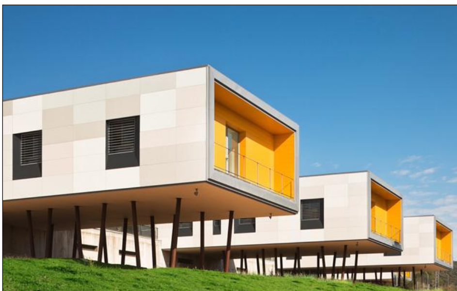
Εικόνα 6-7: Εξωτερική επένδυση κτηρίων με HPL
