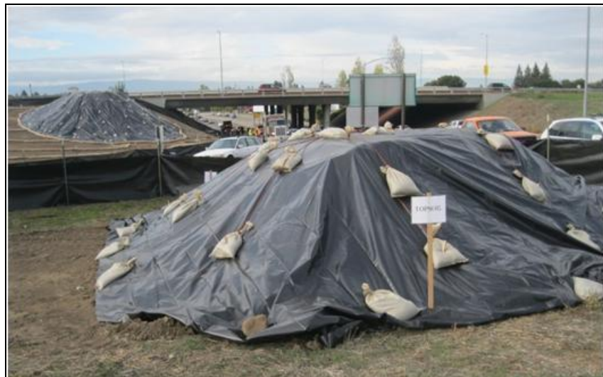
Εικόνα 9-5: Κάλυψη μπαζών/αδρανών υλικών
