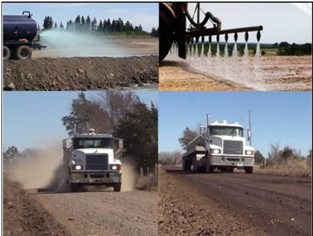
Εικόνα 9-4: Μέθοδος διαβροχής χωμάτων οδών για τον περιορισμό εκπομπής σκόνης
