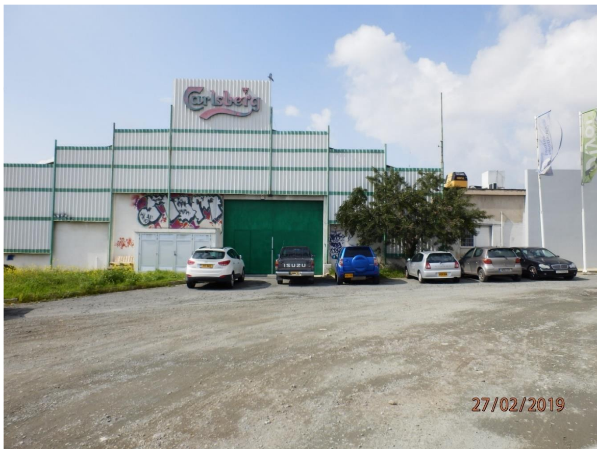
Φωτογραφία 9.39: Βιομηχανική ανάπτυξη στα δυτικά της περιοχής του προτεινόμενου Έργου.
