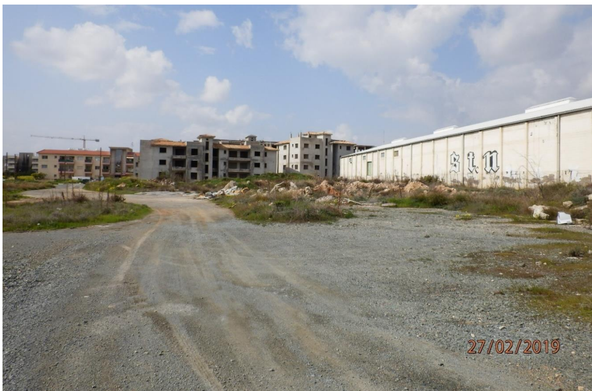
Φωτογραφία 9.44: Άδεια τεμάχια και στο βάθος μη-ολοκληρωμένες κατοικίες (φαινομενικά εγκαταλειμμένη κατασκευή), όπως και μερικές ολοκληρωμένες πολυκατοικίες (στο βάθος αριστερά) που φαίνονται από τη Λεωφόρο Αγίου Αθανασίου, στα δυτικά του Έργου.
