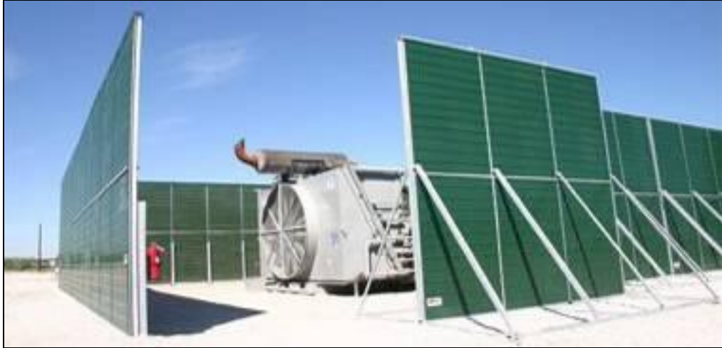
Εικόνα 9-2: Χρήση ηχοπετασμάτων σε σταθερές πηγές θορύβου
