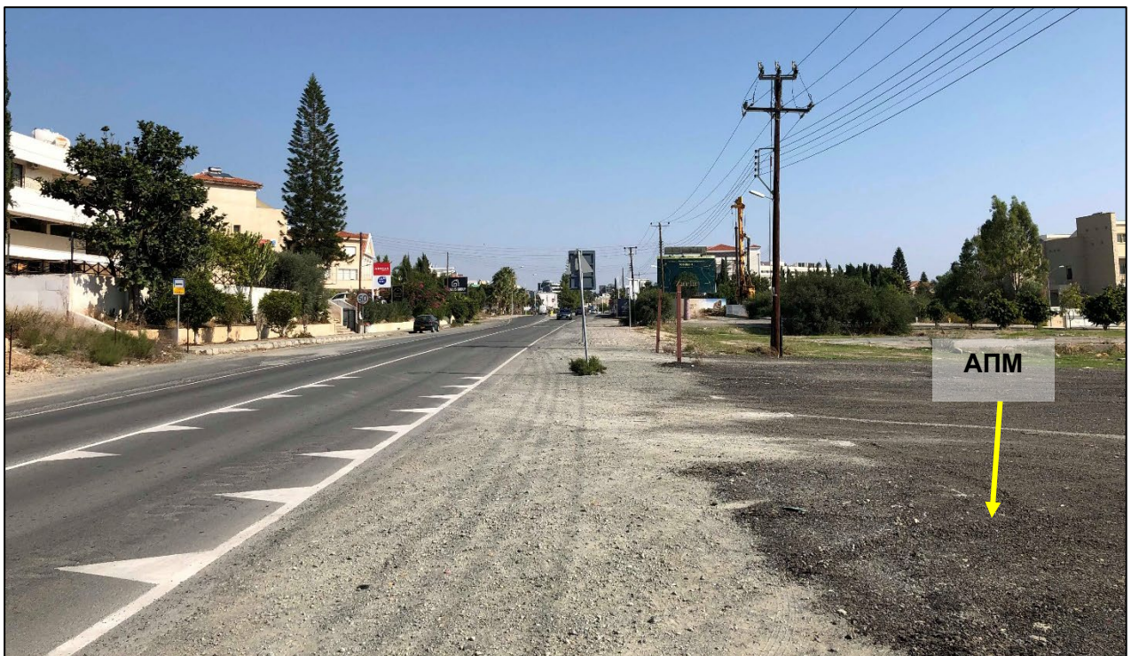
Φωτογραφία 7: Βόρειο σύνορο του υπό μελέτη τεμαχίου εφάπτεται με εγγεγραμμένο δρόμο, την κύρια οδό Λευκωσίας – Λεμεσού (B1)
