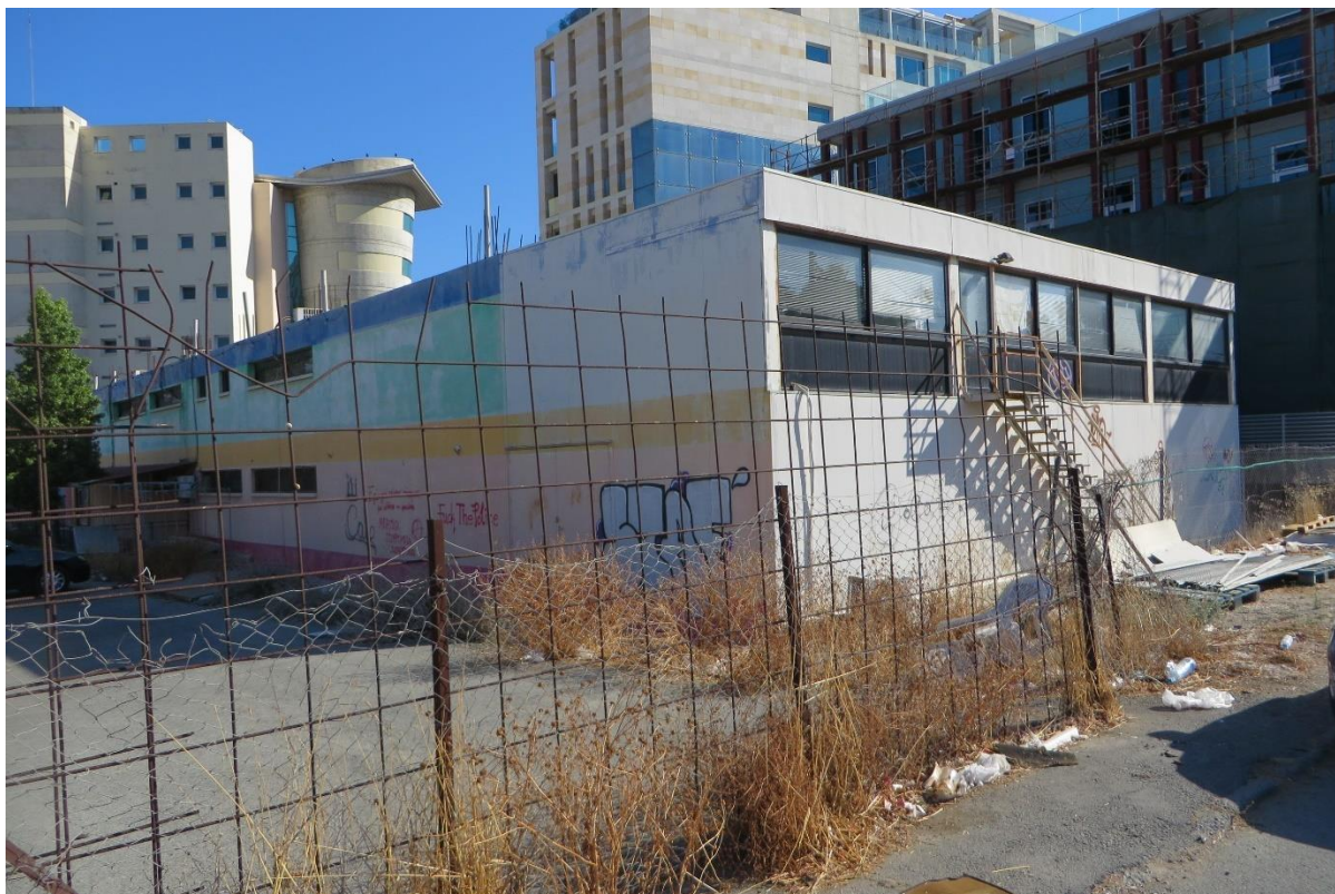
Φωτογραφία 9.4: Εγκαταλειμμένο κτήριο που βρίσκεται δυτικά του χώρου ανάπτυξης
