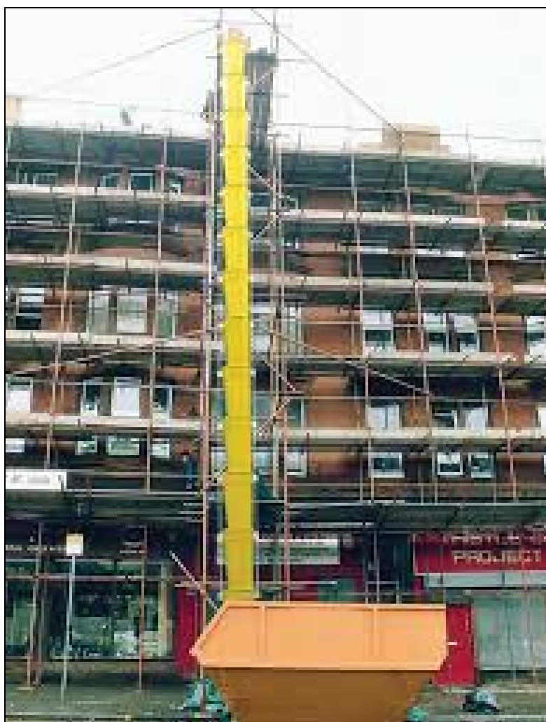
Εικόνα 9-7: Σωλήνας μεταφοράς σκουπιδιών (waste chute)
