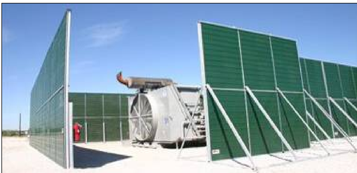
Εικόνα 9-1: Χρήση ηχοπετασμάτων σε σταθερές πηγές θορύβου
