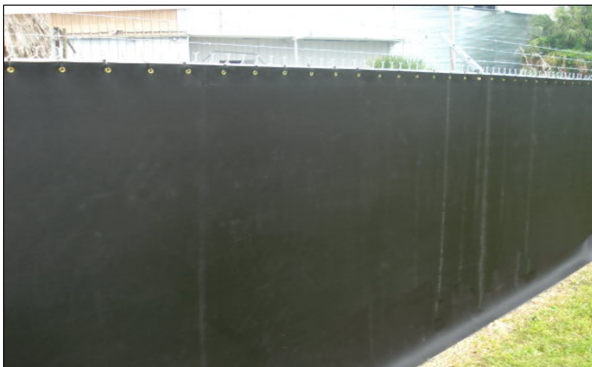
Εικόνα 9-3: Περίφραξη από συμπαγή υλικά
