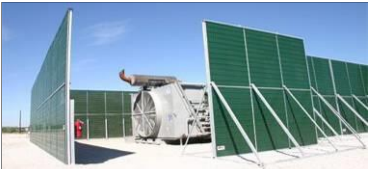
Εικόνα 9-1: Χρήση ηχοπετασμάτων σε σταθερές πηγές θορύβου
