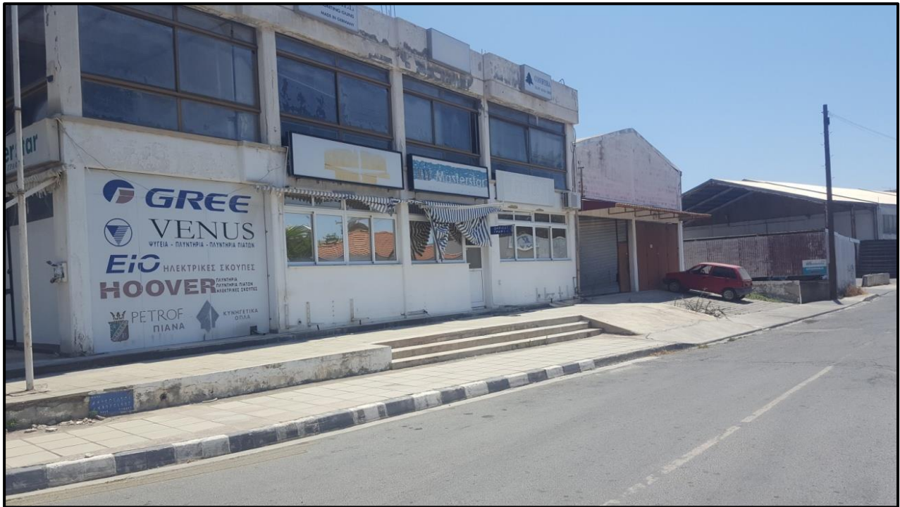
Φωτογραφία 6-2: Κτήρια προς κατεδάφιση στο τεμάχιο 270
