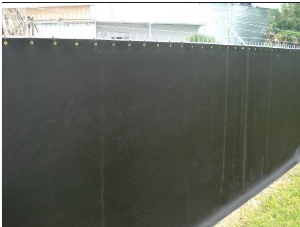
Εικόνα 9-3: Περίφραξη από συμπαγή υλικά
