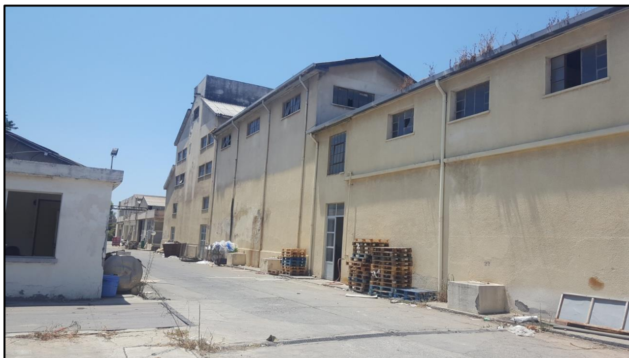
Φωτογραφία 6-1: Κτήρια προς κατεδάφιση στο τεμάχιο 142
