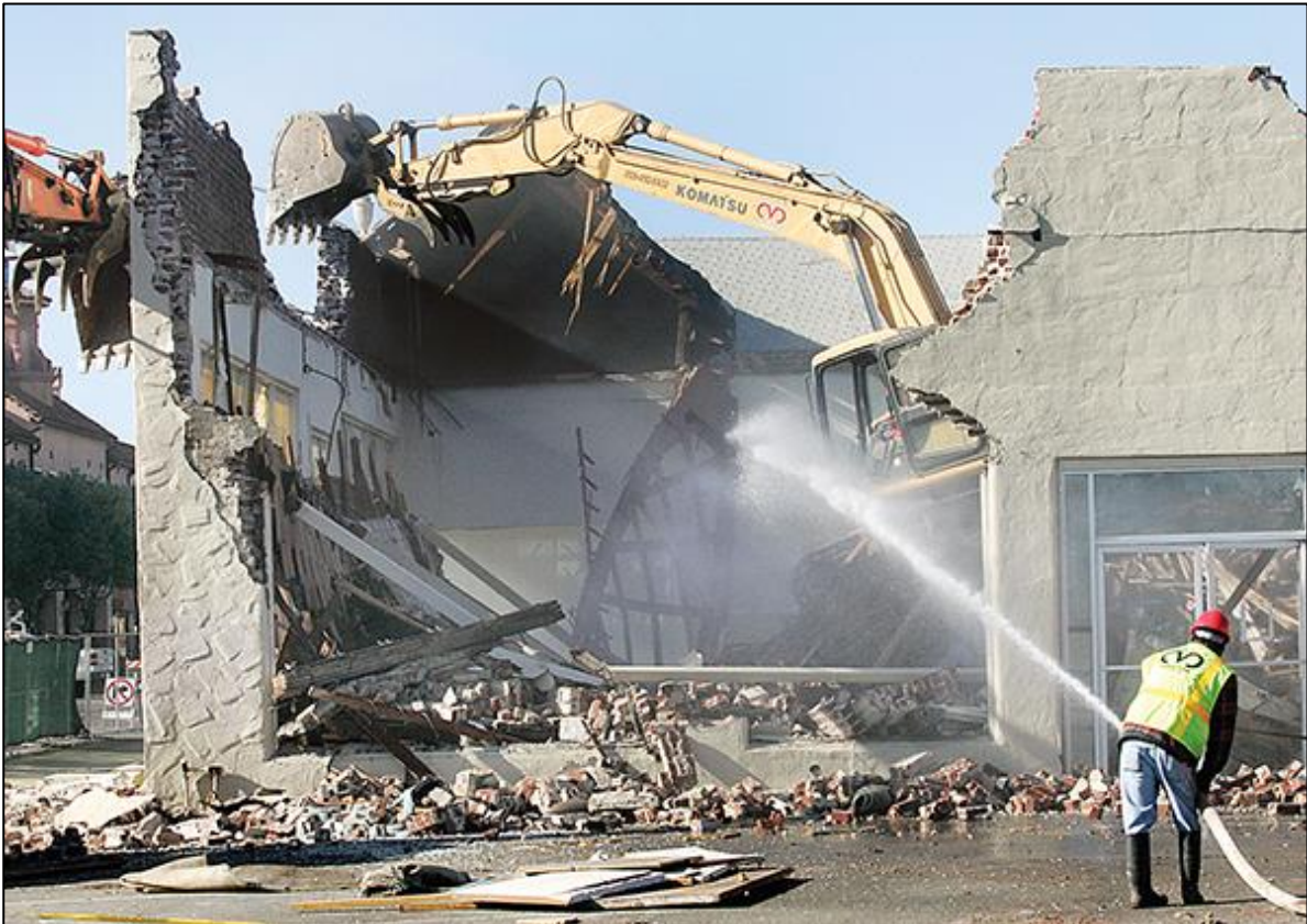
Εικόνα 9-6: Διαβροχή του χώρου κατεδάφισης
