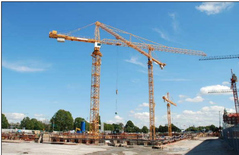
Εικόνα 6-12: Γερανός σταθερής βάσης
