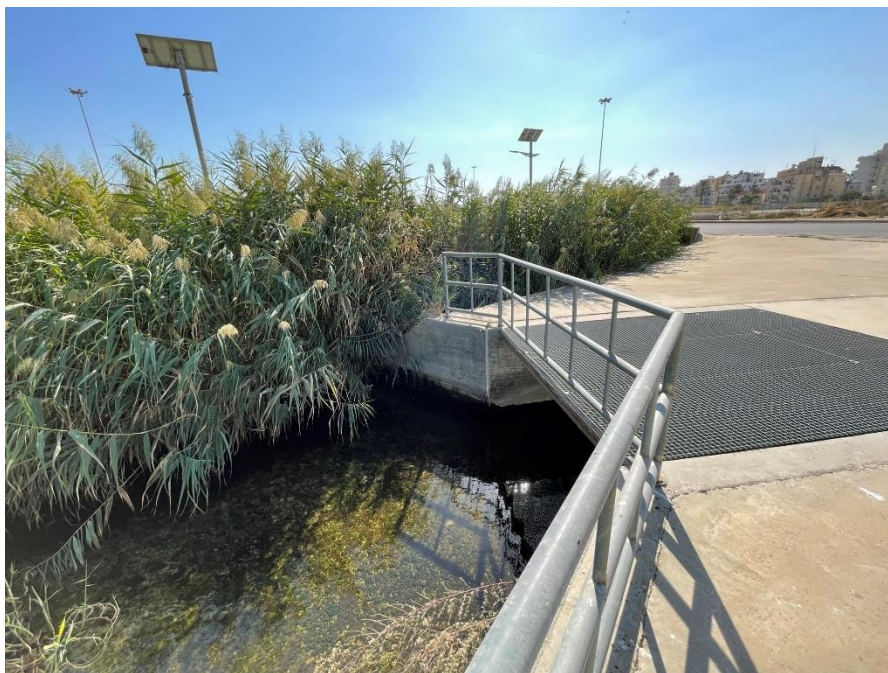
Εικόνα 4-15: Λιμένας Λάρνακας. Σημείο εκροής ενός εκ των καναλιών της λεκάνης του Λιμένα.
