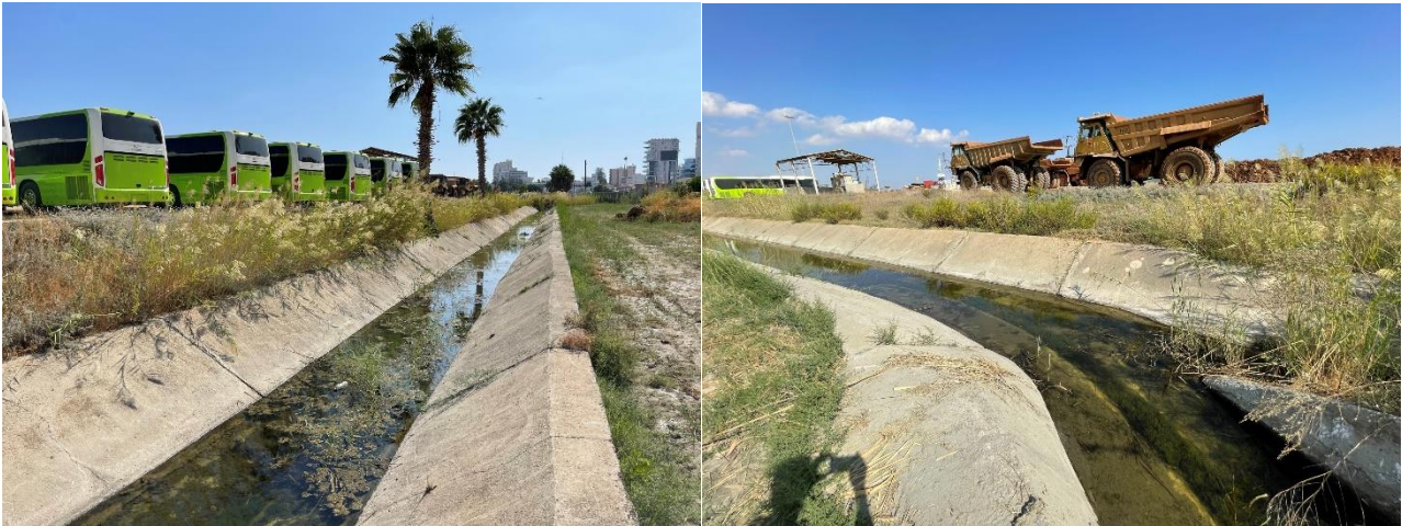
Εικόνα 4-13 & 4-14: Λιμένας Λάρνακας. Περιοχή νότια αποβάθρας.
