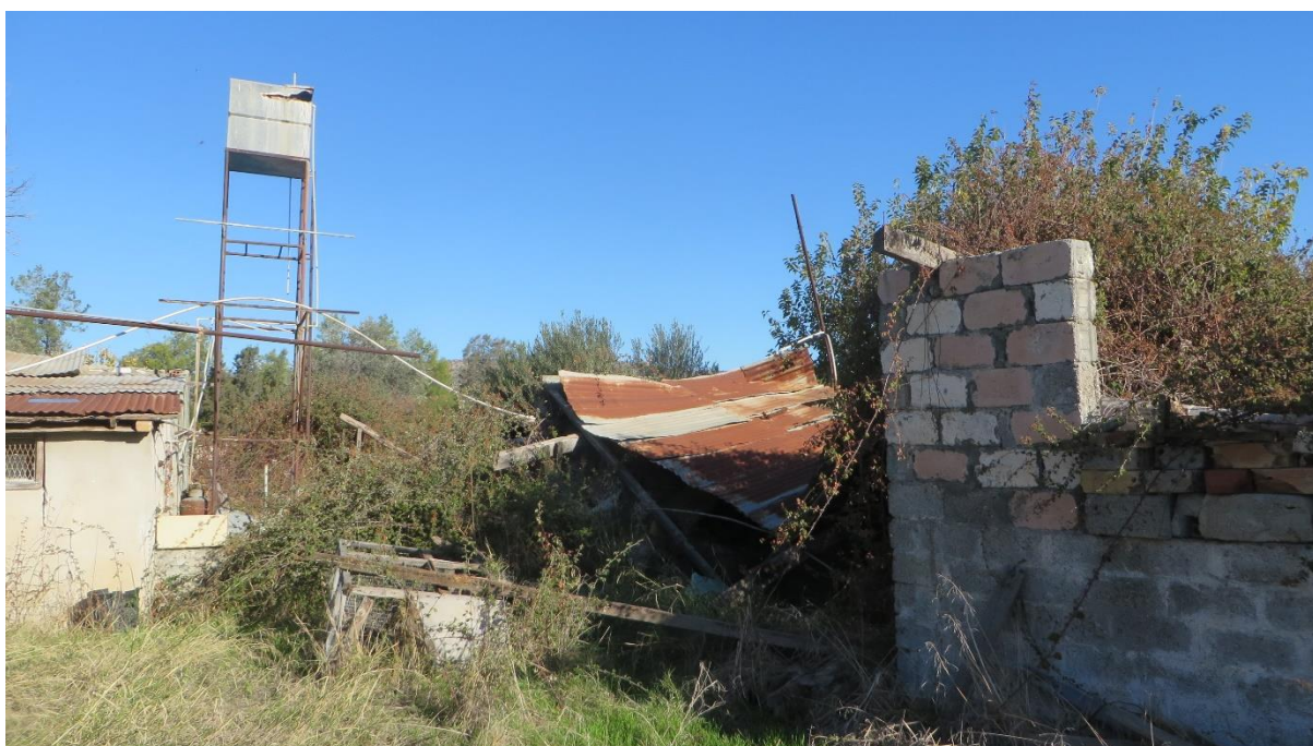
Φωτογραφία 7.21: Εγκαταλελειμμένος χώρος σε απόσταση περίπου 140 μέτρα ανατολικά του χώρου ανάπτυξης
