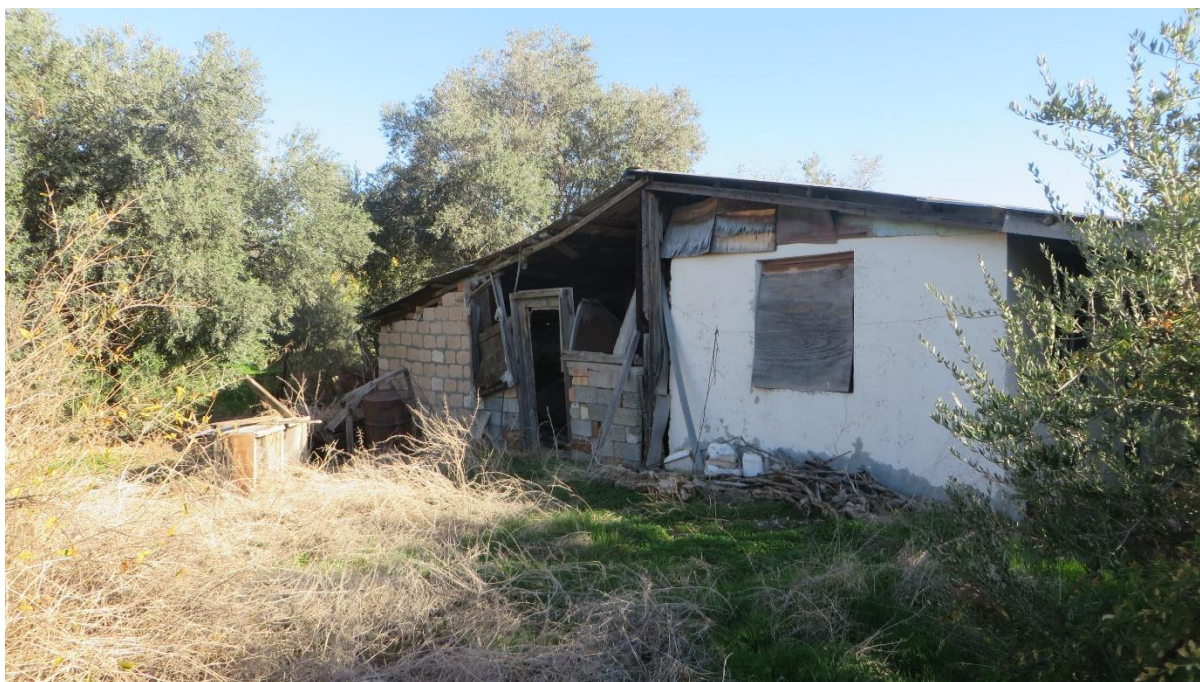
Φωτογραφία 7.22: Εγκαταλελειμμένος χώρος σε απόσταση περίπου 140 μέτρα ανατολικά του χώρου ανάπτυξης
