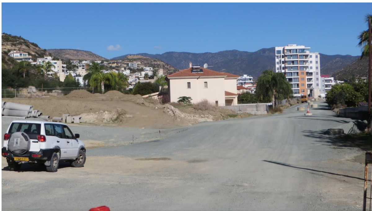
Φωτογραφία 7.12: Κατασκευαστικά έργα σε απόσταση περίπου 270 μέτρα βόρεια του χώρου ανάπτυξης
