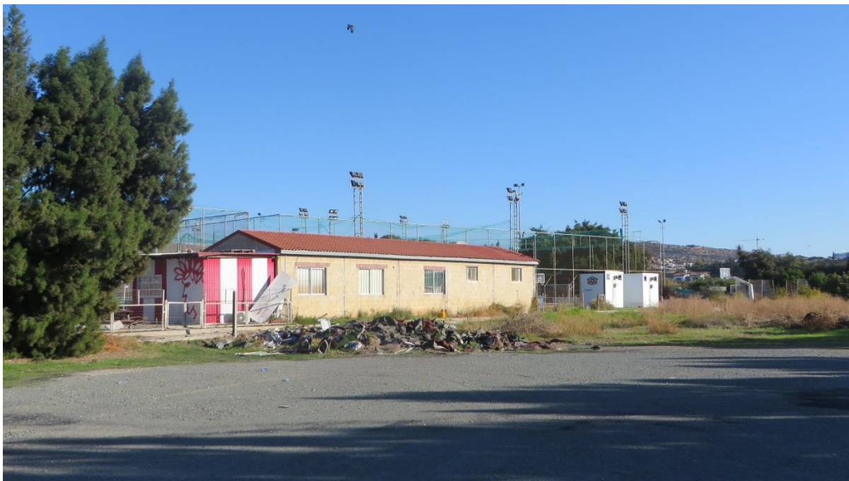
Φωτογραφία 7.28: Αθλητικές εγκαταστάσεις και διάφορα υλικά (λάστιχα, ρούχα, κ.λπ.) που απορρίπτονται στο χώρο σε απόσταση περίπου 50 μέτρα ανατολικά του χώρου ανάπτυξης
