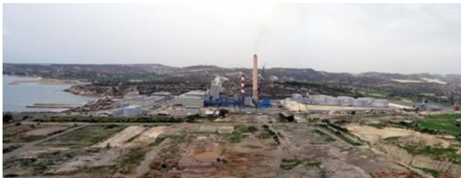
Εικόνα 6-58. Μέρος του Ενεργειακού Κέντρου και Σταθμός Ηλεκτροπαραγωγής ΑΗΚ.
