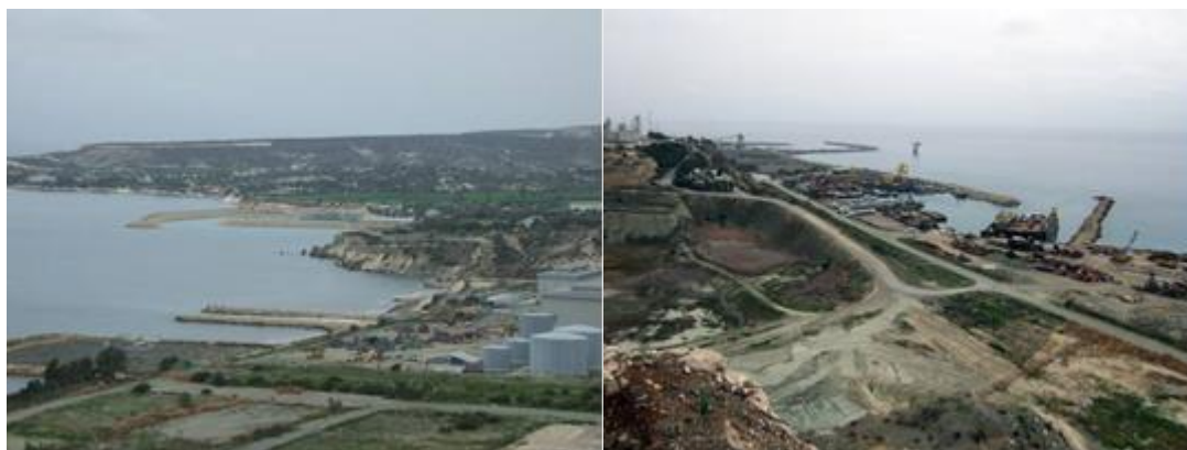
Εικόνα 6-56. Λιμάνια και άλλες ανθρωπογενείς κατασκευές κατά μήκος της παράκτιας ζώνης.
