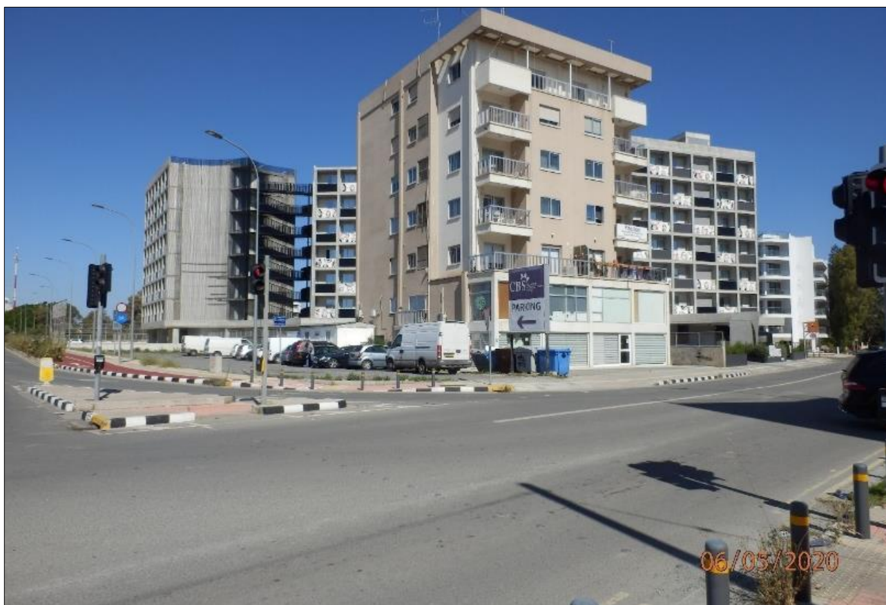
Φωτογραφία 7.30: Φοιτητικές εστίες και άλλες χρήσεις, στην περιοχή ανατολικά του Έργου
